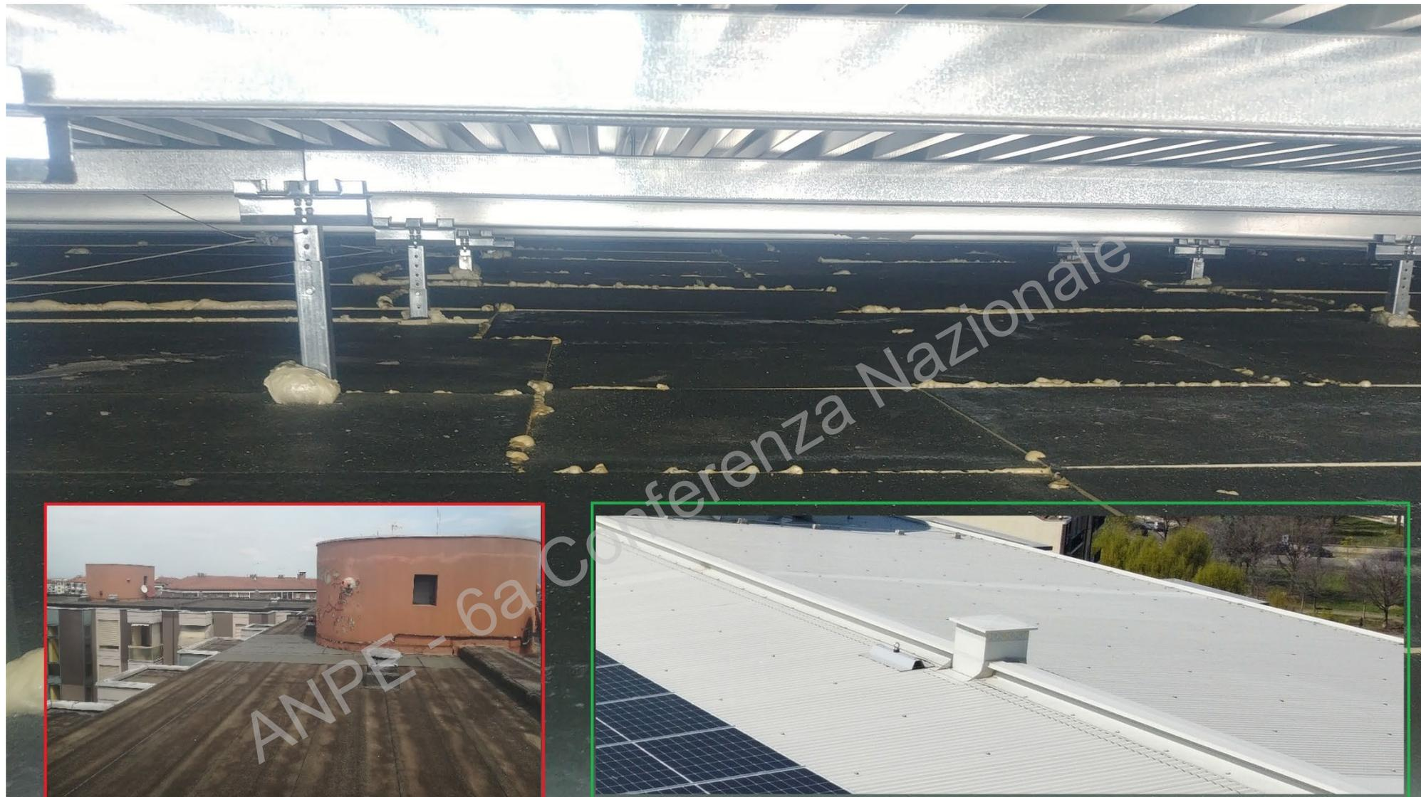
Copertura piana convertita in copertura ventilata
