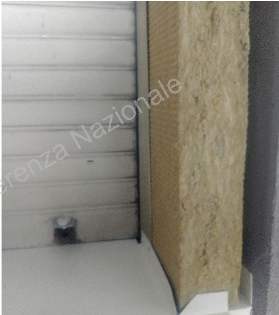
Correzione ponte termico spalletta serramento
