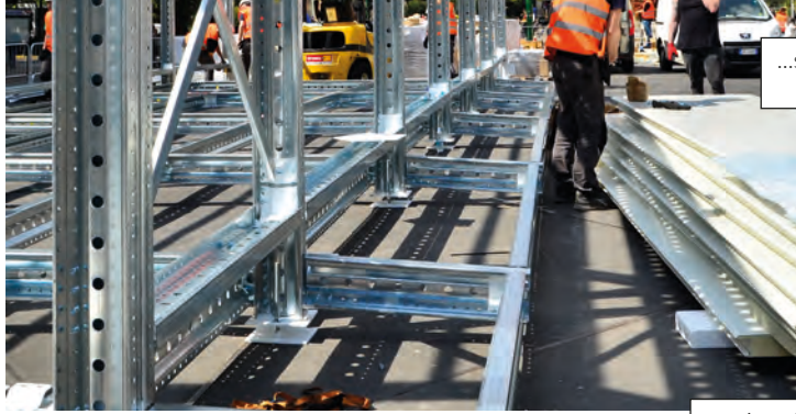
...e si posiziona l'impalcato in pannelli sandwich.
