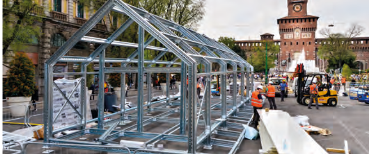
Si procede con i pannelli in copertura e in parete.
