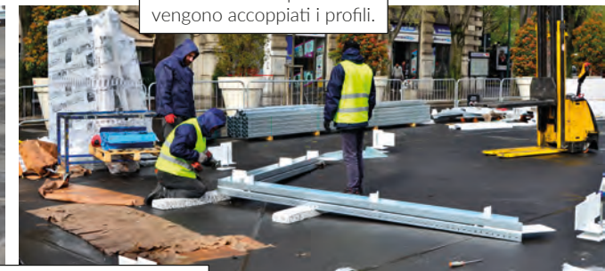
...si collegano con le travi trasversali.
