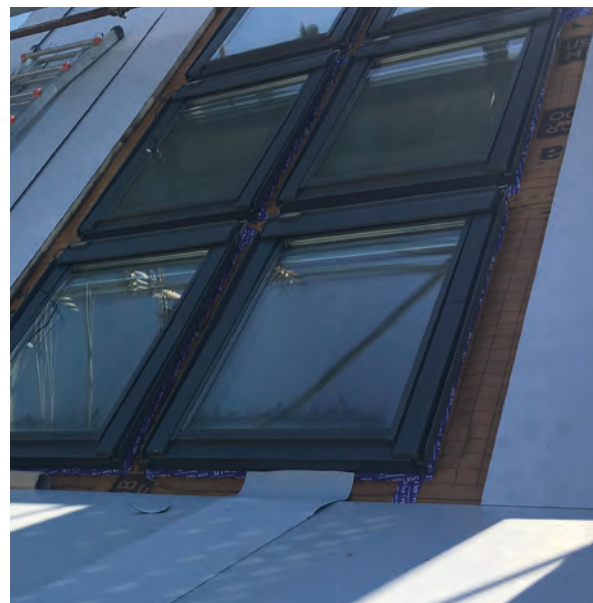
Figura 3.12. Foto di posa del prototipo di chiusura C.O. 02 MODERN
